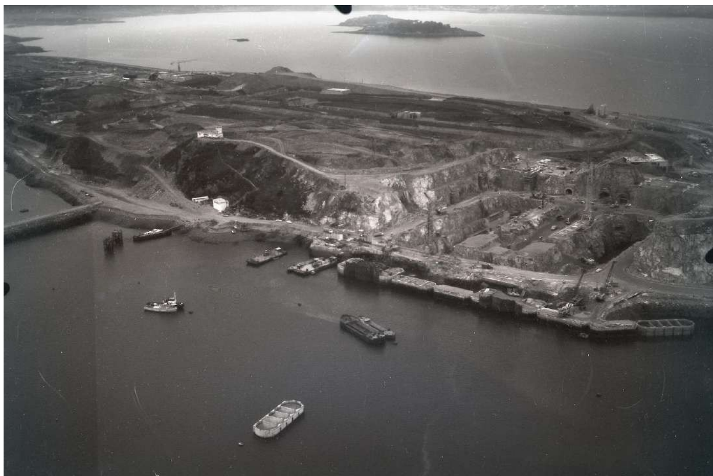
Figure 54 : Les deux bassins en cours de construction, milieu de l'année 1968 (Fonds privé Yves Cariou).
