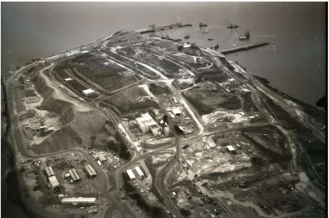
Figure 53 : Photo prise de la partie nord de l'Île Longue durant l'année 1968, avec l'impressionnant tracé des routes de communication pour le bon déroulement du chantier (Fonds privé Yves Cariou).
