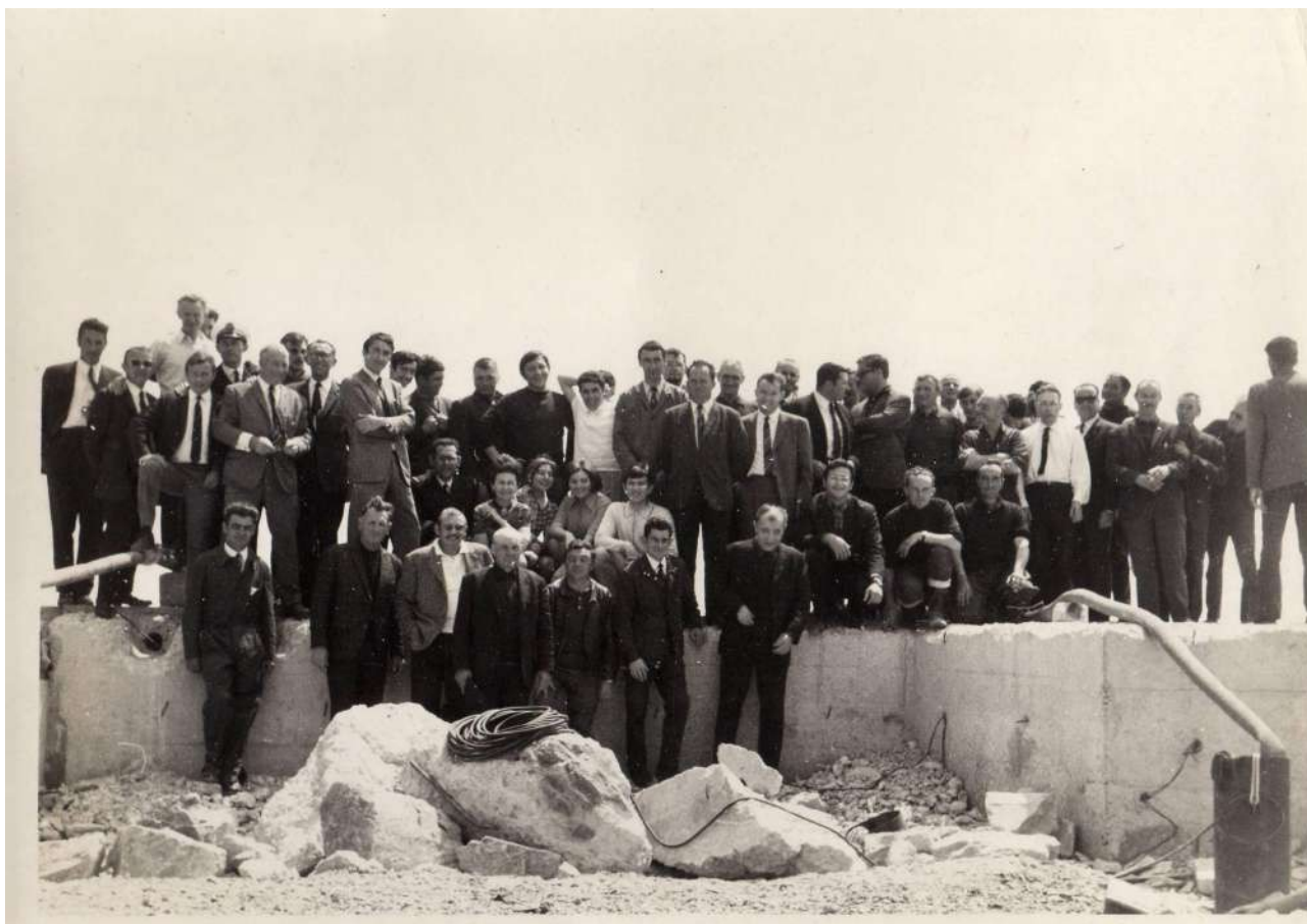
Figure 50 : Tous les ingénieurs et techniciens des Travaux Maritimes affectés à la construction de la base rassemblés sur le chantier pour une photo souvenir (Fonds privé Yves Cariou).
