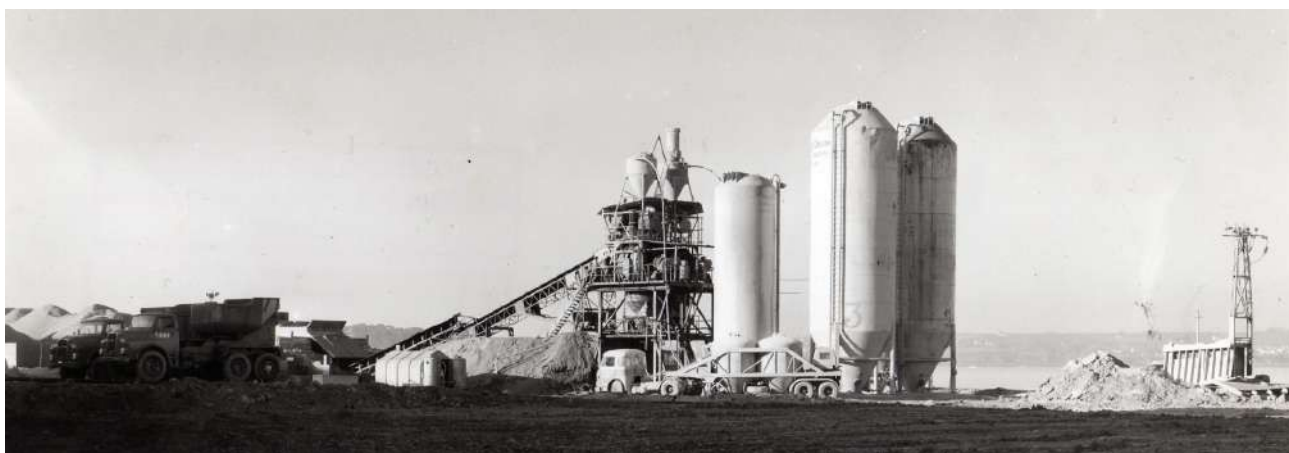
Figure 51 : Centrale à béton sur le chantier de l'Île Longue en 1967 (Fonds privé Yves Cariou).
