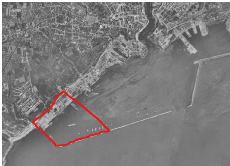
Figure 14 : La grande jetée sud comprenant l'ancienne base sous-marine allemande de Laninon ( https://www.geoportail.gouv.fr/donnees/photographies-aeriennes-1950-1965 )
