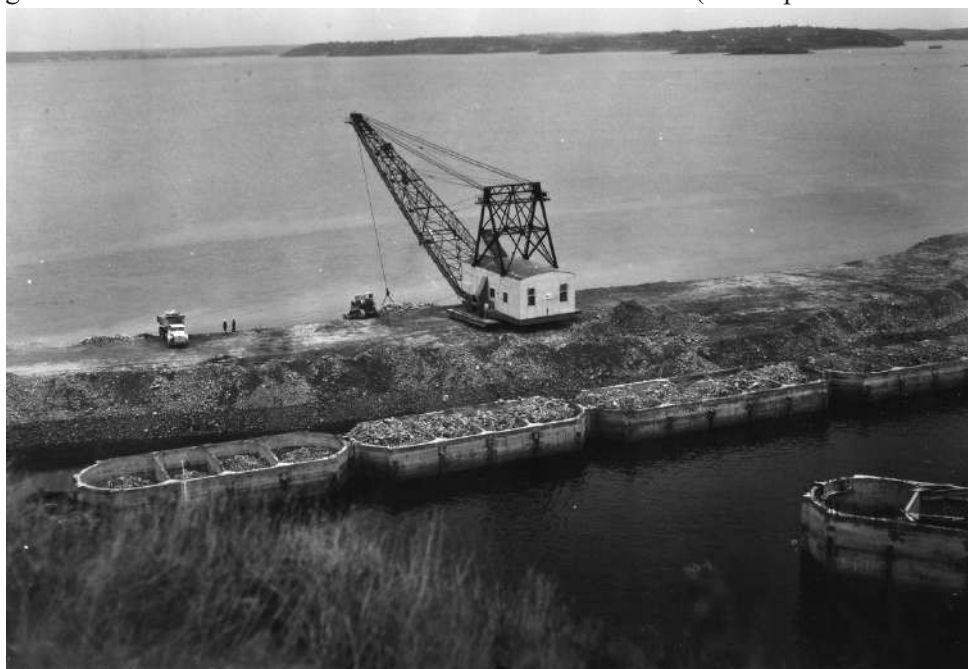
Figure 64 : Les caissons sont amenés à l'Île Longue pour la construction de la jetée (Fonds privé Yves Cariou).
