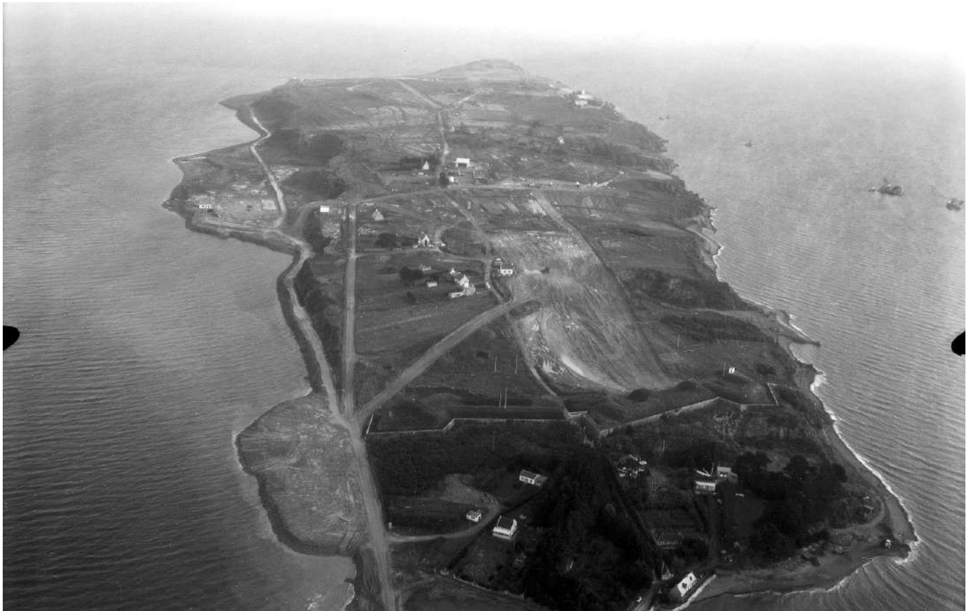
Figure 47 : On suppose que la photo a été prise à la fin de l'année 1967, au début des travaux de terrassement. Les quelques habitations de Kernaléguen et de Kermeur subsistent toujours au centre de l'île. Au sud de l'Île, on retrouve les maisons de relogement en attendant les habitations du Zorn. Le Mur de retranchement de l'Île Longue porte bien son nom (Fonds privé Yves Cariou).
