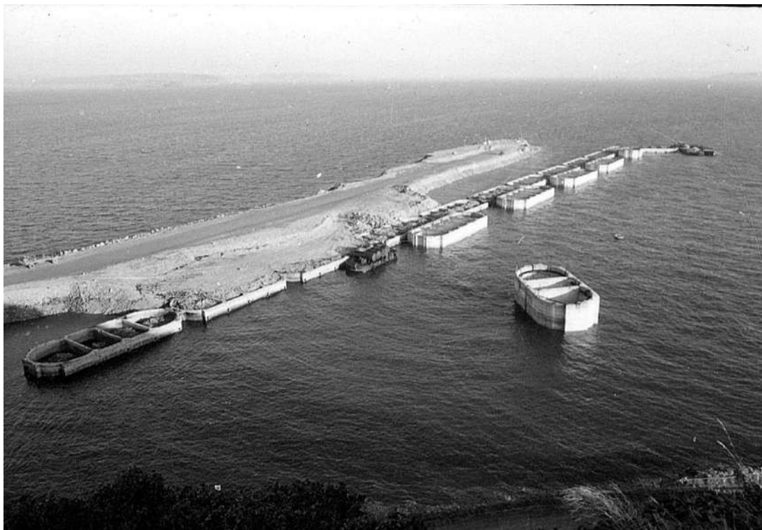
Figure 65 : Photo de la jetée en construction (Fonds privé Yves Cariou).
