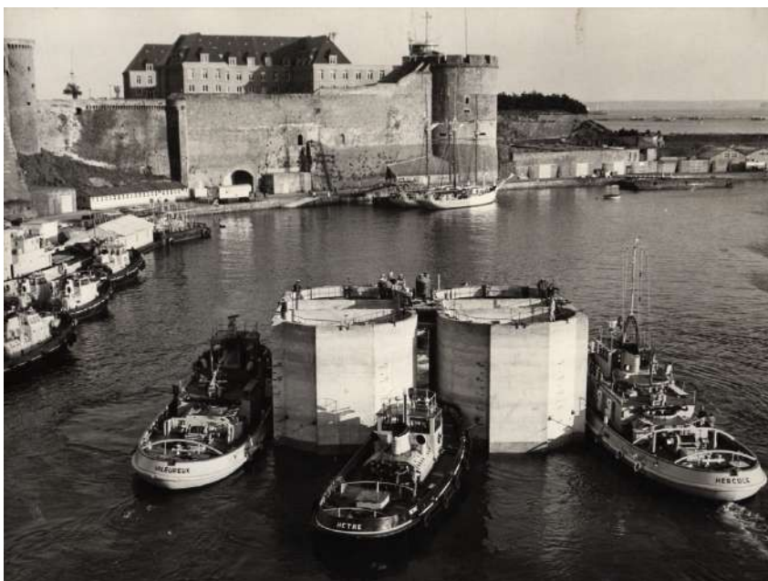
Figure 63 : Photo des caissons sortant de la Penfeld en 1968 (Fonds privé Yves Cariou).
